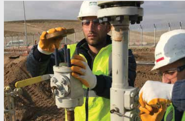
Tekfen / TANAP, Doğalgaz Boru Hattı Servisi, 2017
