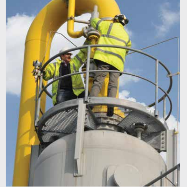
TPAO Silivri Doğalgaz Depolama, 2012
