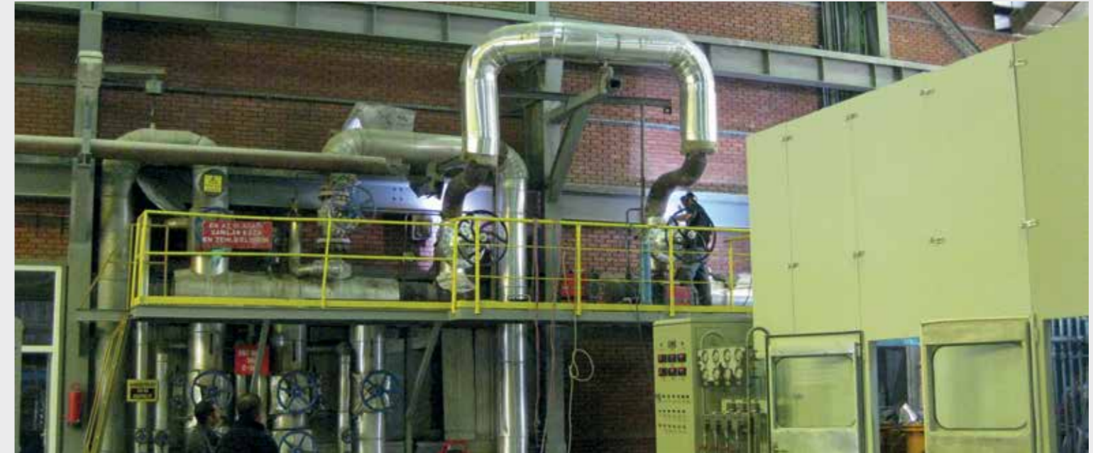
Eti Kirka Bor Tesisi / Eskişehir, 2012
