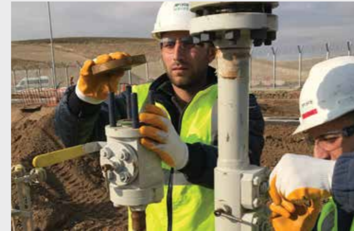
Tekfen / TANAP, Doğalgaz Boru Hattı Servisi, 2017
